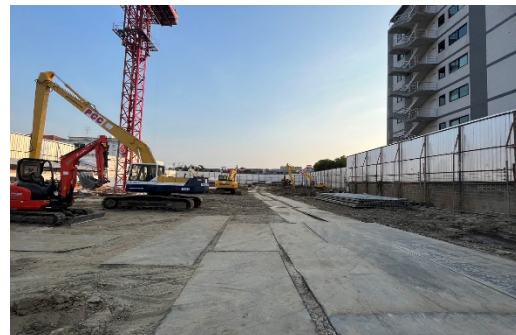
รูปที่ 21 แผ่นเหล็กปูทั่วพื้นที่โครงการ
