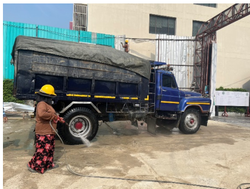
รูปที่ 19 การฉีดล้างล้อรถบรรทุกก่อนออกนอกบริเวณโครงการ
