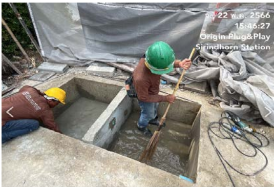
รูปที่ 12 ปอดักตะกอนดิน
