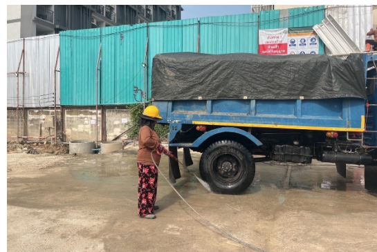
รูปที่ 19 การฉีดล้างล้อรถบรรทุกก่อนออกนอกบริเวณโครงการ
